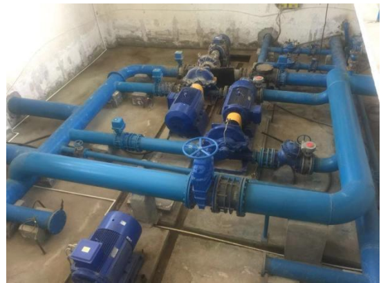
更换泵房设备
